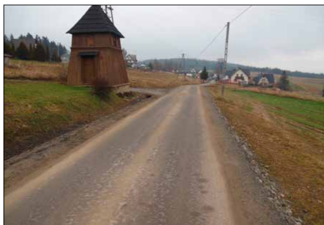
Droga Orawka - Studzianki w miejscowości Orawka
